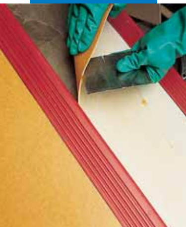
Нанесение Adesilex VZ на тыльную сторону покрытия из ПВХ.
