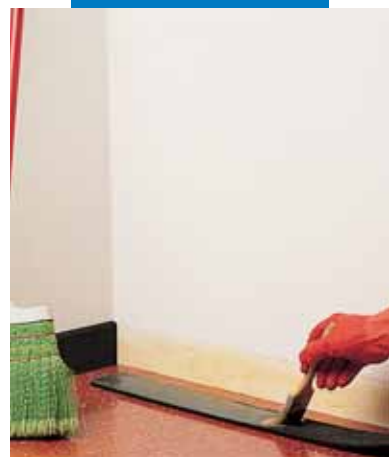
Нанесение Adesilex VZ на тыльную сторону плинтуса
