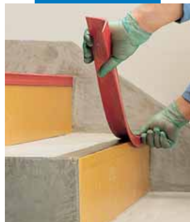
Приклеивание внешнего уголка из ПВХ для ступени
