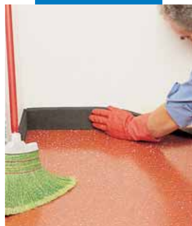
Приклеивание плинтуса из ПВХ
