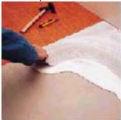
Нанесение ADESILEX V4 перед установкой гомогенных листов ПВХ
