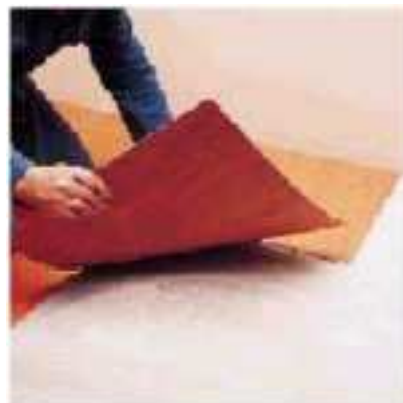
Гомогенные листы ПВХ, устанавливаемые на ADESILEX V4
