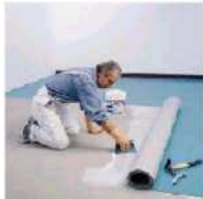
Гомогенные рулоны ПВХ, устанавливаемые на ADESILEX V4
