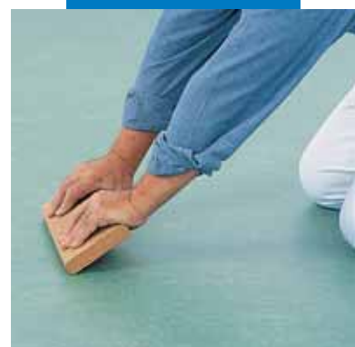
Прижатие шва линолеумного покрытия
