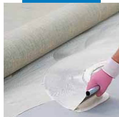
Укладка линолеума на Aquasol T
