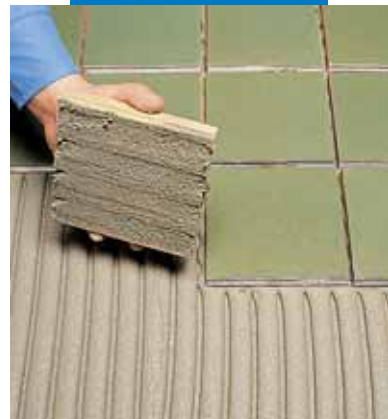
Укладка экструдированной плитки
