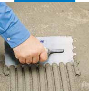
Нанесение клея шпателем с закругленными зубцами
