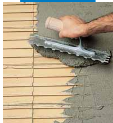
Укладка ребристой экструдированной плитки методом двойного нанесения
