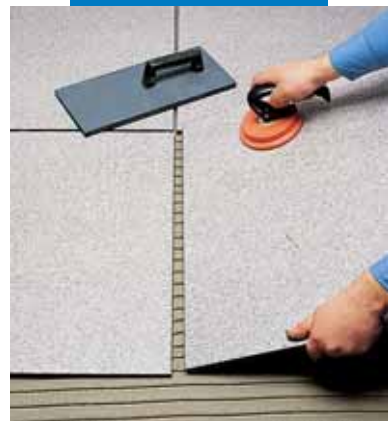
Укладка плитки одинарного обжига размером 60x60 см
