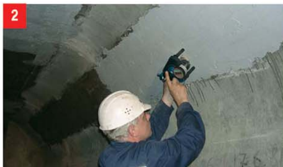
Испытания на фиксацию с помощью металлических штампов диаметром 50 мм
