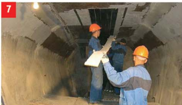
Установка углеродных лент Sika® CarboDur®. Дожатие ленты роликом
