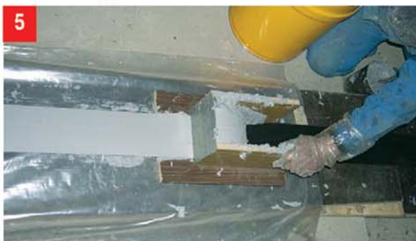
Укладка клея Sikadur®-30 на ленту в виде куполообразного профиля
