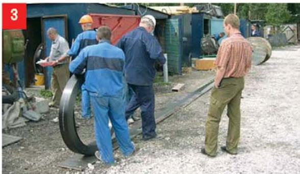
Подготовка углеродных лент Sika® CarboDur® на стройплощадке
