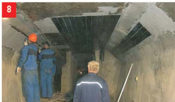
Общий вид установленных первых 15-ти углеродных лент Sika® CarboDur® типа S1214
