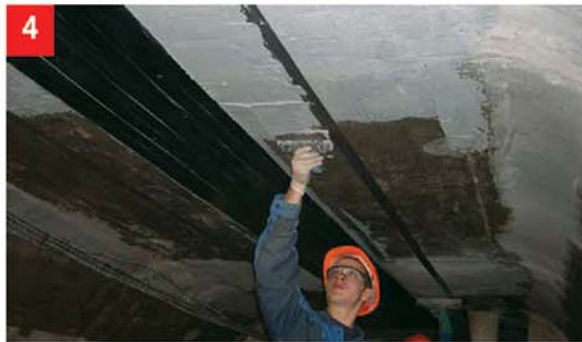
Укладка эпоксидного клея Sikadur®-30 на основание
