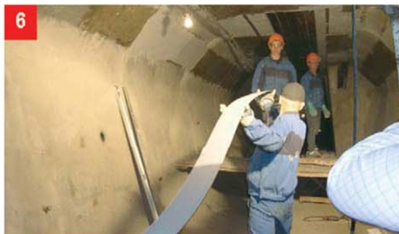
Примерка ленты Sika® CarboDur® для установки в требуемое положение
