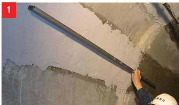
Участки с неровной поверхностью были репрофилированы эпоксидным раствором Sikadur®-41
