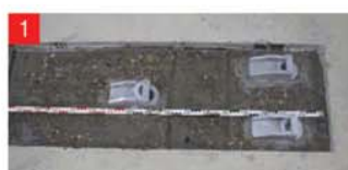
Подготовленные предварительно напряженные каналы с установленными металлическими анкерными закладными
