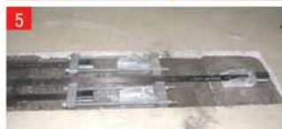
Завершающее состояние трех предварительно напряженных элементов, расположенных с зазором (один зафиксирован неподвижно, два установлены с подвижным креплением)
